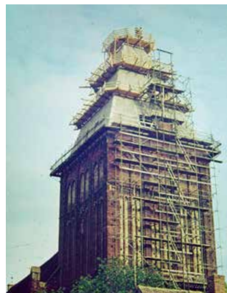
Bild aus den frühen sechziger Jahren von den damaligen Reparaturarbeiten am Jacobiturm nach dem großen Brand.
